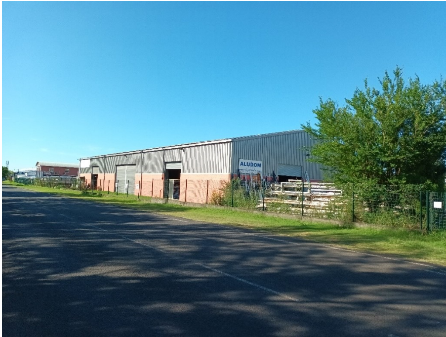
Figure 13 : Photo 7 – Vue des entreprises ALUDOM et JPGRANIT depuis l’avenue Michel Debré
